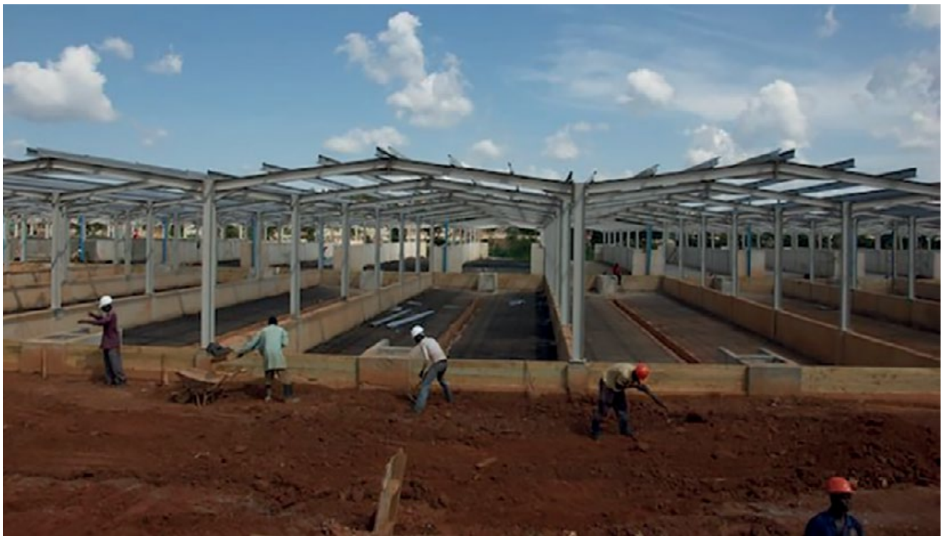
Figura 18.1 La construcción de lechos de secado en la Estación de Tratamiento de Lodos Fecales Lubigi, como parte de la Primera Etapa del Proyecto de Protección de Lago Victoria, con financiamiento de la Unión Europea, el KfW del Gobierno Alemán y el NWSC del Gobierno de Uganda (foto: Lars Schoebitz).
