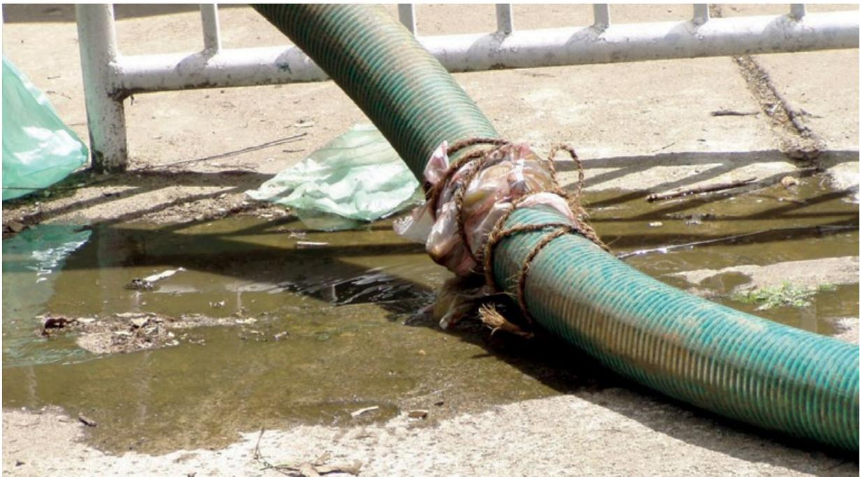
**Figura 4.4** Las mangueras y sus accesorios requieren frecuente atención y reparación para mantenerles funcionando debidamente. Esta foto muestra un caso de mantenimiento inadecuado, con fugas de LF que salen de roturas en una manguera (foto: David M. Robbins).
