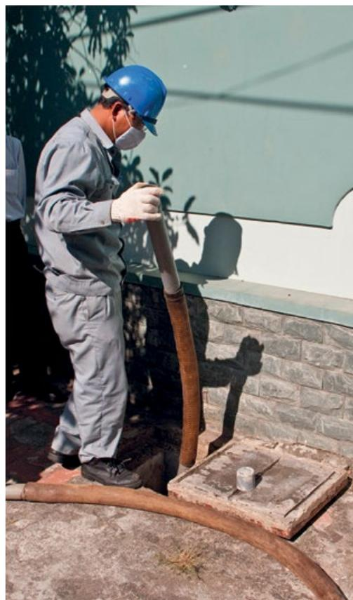
**Figura 4.3** Ejemplo de un tanque séptico con la tapa bien diseñada para fácil acceso, en la provincia Vung Tau de Vietnam (foto: Linda Strande).
