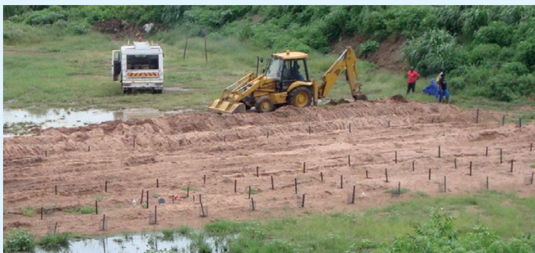
Figura 5.4 Sitio de ensayos del entierro en zanjas profundas en Umlazi, con la colocación de lodos fecales en trincheras de un metro de profundidad (arriba) y árboles sembrados encima de los hoyos rellenados (abajo). El agua de los pozos locales fue monitoreada por posible contaminación de nutrientes, sustancias orgánicas y patógenos (fotos: Jay Bhagwan del Consejo de Investigación del Agua, Sudáfrica).
