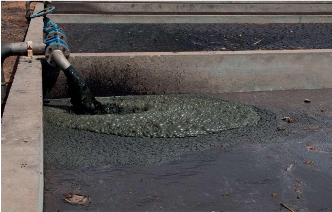
Figura 7.4 Carga de lodos sobre los lechos de secado en la Estación de Tratamiento de Lodos Fecales Niayes, en Dakar, Senegal (foto: Linda Strande).
