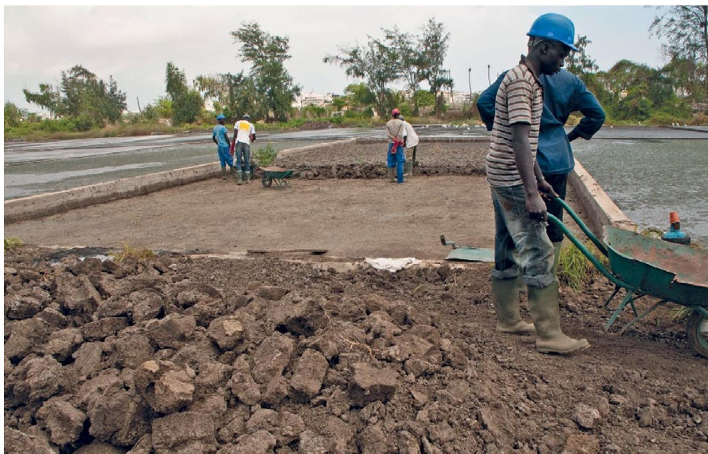
Figura 7.5 Extracción de lodos de los lechos de secado sin plantas en la Estación de Tratamiento de Lodos Fecales Cambéréne, en Dakar, Senegal. En primer plano, se observan los lodos ya sacados (foto: Linda Strande).
