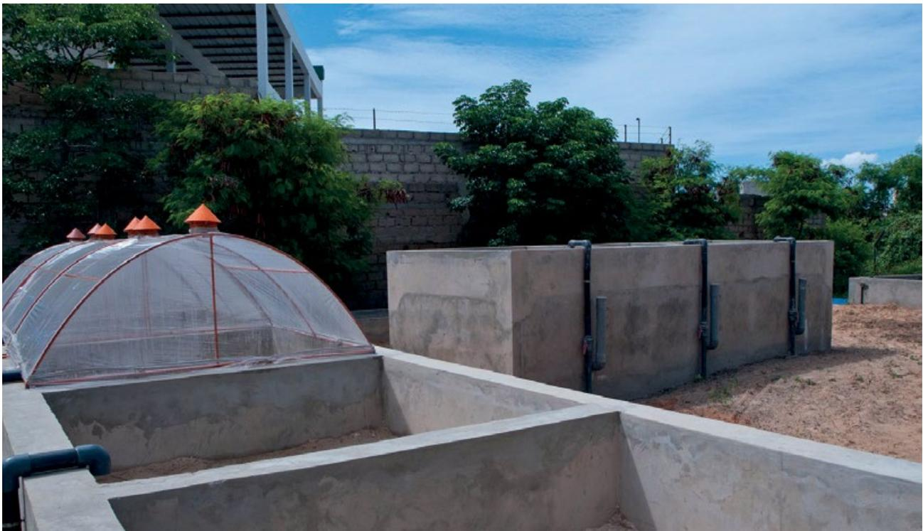
**Figura 7.7** Proyecto piloto acerca de la separación del agua presente en los lodos fecales, mediante invernaderos con ventilación activa y pasiva, dentro de la Estación de Tratamiento de Lodos Fecales Cambérène, en Dakar, Senegal (foto: Linda Strande).
