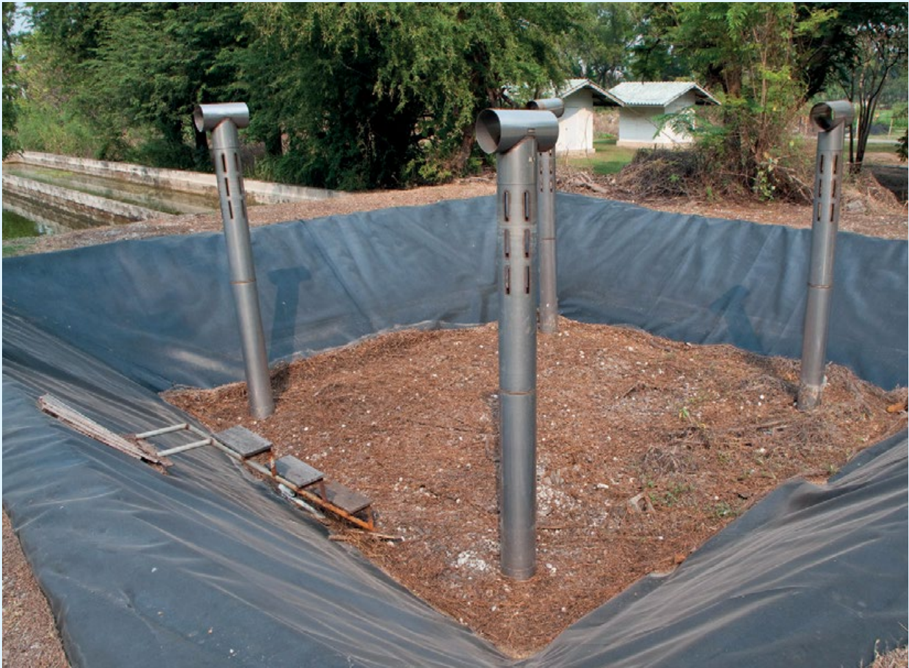
Figura 8.4 Lecho de secado con plantas a escala piloto, hecho por el Instituto Asiático de Tecnología (AIT), en el cual se observan los tubos de ventilación, pero no se ven plantas, ya que no estaba en uso (foto: Linda Strande).
