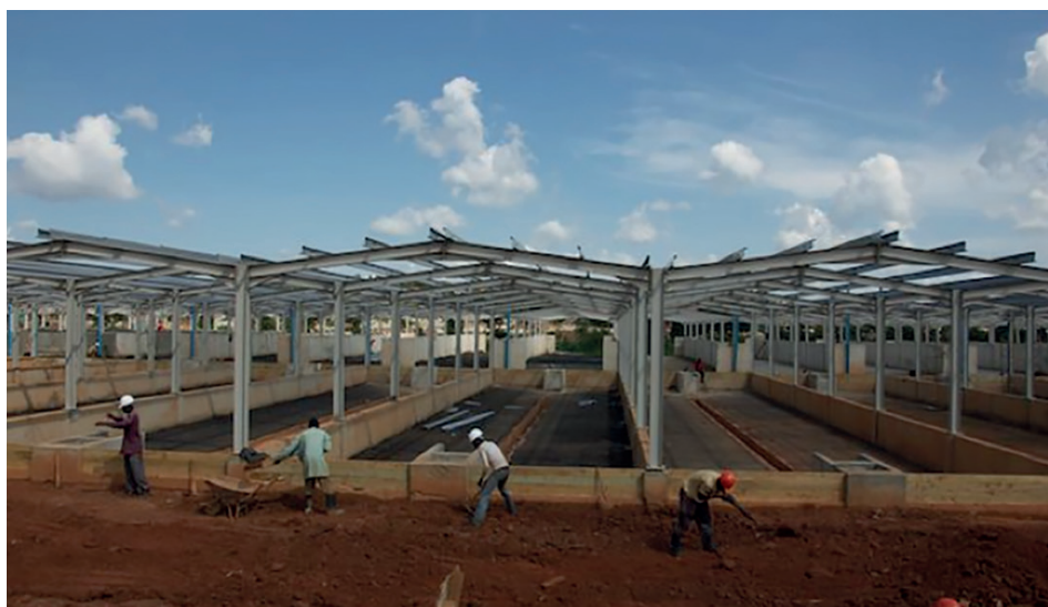
Figure 18.1 : Lits de séchage pour le traitement des boues de vidange en cours de construction sur le site de Lubigi à Kampala. Étape 1 du projet de protection du lac Victoria financé par la KfW, l'UE et le gouvernement ougandais (NWSG) (photo : Lars Schoebitz).
