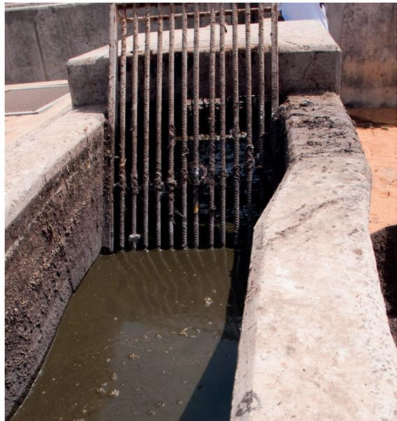
Figure 3.6 : Dégrilleur de la station de traitement des boues de vidange de Niayes, Dakar, Sénégal (photo : Linda Strande).
