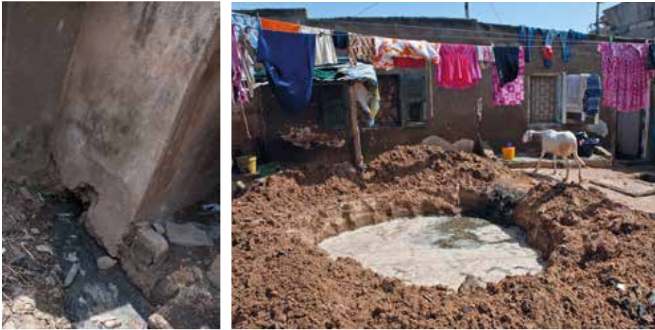
Figure 1.2 : Boues de vidange issues de latrines directement déversées dans un canal de drainage à Kampala, Ouganda (gauche), et vidange des boues d'une fosse septique à proximité d'une habitation à Dakar, Sénégal (photos : Linda Strande).
