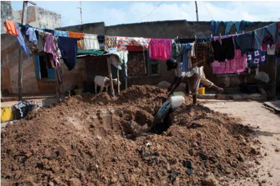
Figure 14.9 : Vidange manuelle de boues avec enfouissement dans la cour (photo : Linda Strande).
