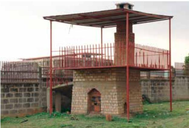
Figure 18.6 : Le four pilote du projet FaME (Faecal Management Enterprises) pour la cocombustion des boues de vidange destinée à la production de briques à Kampala, Ouganda (photo : Pitman Ian Tushememizwe).
