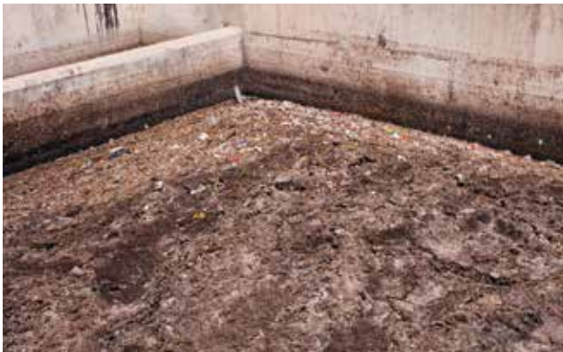
Figure 3.2 : Bassin de décantation de la station de traitement des boues de vidange de Dakar, Sénégal (photo : Linda Strande).
