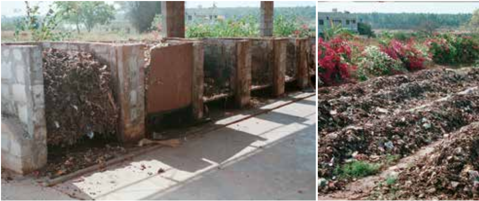
Figure 3.11 : Installation de cocompostage pilote avec des boues de vidange et des déchets municipaux à Bangalore, en Inde (photo : Chris Zurbrugg).
