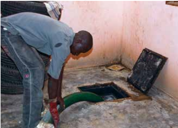
Figure 4.2 : Exemple d'une opération de vidange à Dakar, Sénégal. La fosse est située dans une cour intérieure dont l'accès requiert la concertation entre les résidents (photo : Linda Strande).
