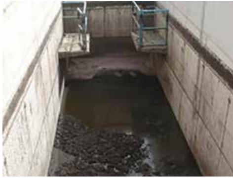
Figure 6.6 : Bassin de décantation et d'épaississement de Rufisque, Dakar, Sénégal, montrant la couche d'écume (photo : Sandec).
