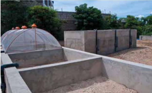
Figure 7.7 : Installation pilote à la station de traitement de Cambéréne, Dakar, Sénégal, pour évaluer la déshydratation possible avec ventilation passive et active, sous serre (photo : Linda Strande).
