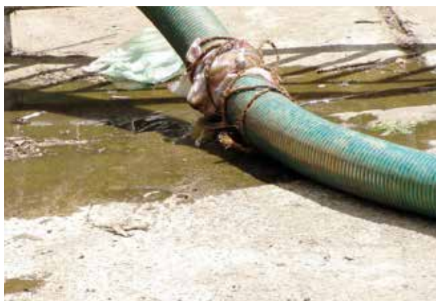
Figure 4.4 : Les tuyaux et accouple-ments doivent être régulièrement contrôlés et changés. Sur cette photographie, des boues fuient car la connexion n'est plus étanche (photo : David M. Robbins).
