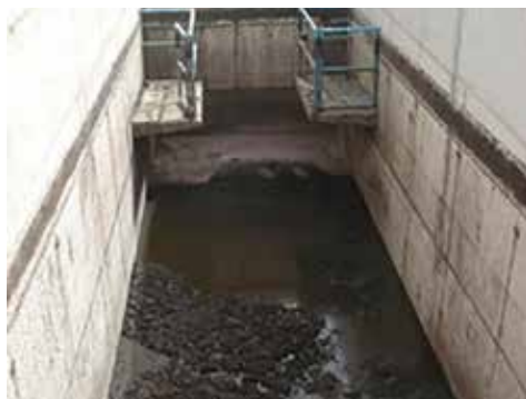
Figure 6.6 : Bassin de décantation et d'épaississement de Rufisque, Dakar, Sénégal, montrant la couche d'écume (photo : Sandec).
