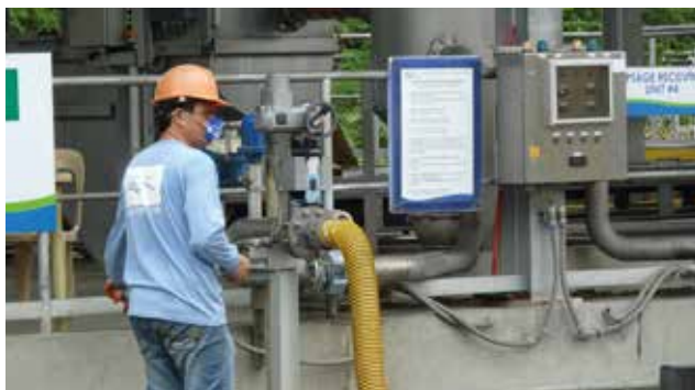
Figure 4.16 : Unité de dépotage mécanisée au niveau de la station d'épuration South Septage de la société Manila Water, à Manille, aux Philippines (photo : WSUP, Sam Parker).
