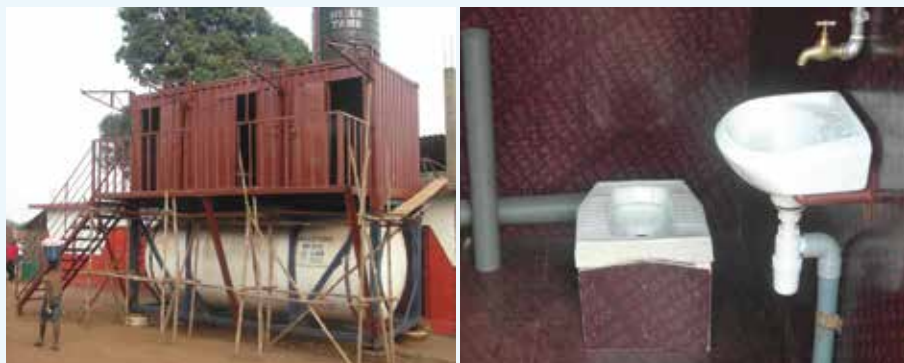
Figure 4.17 : Station de transfert modulaire multifonction de grande capacité et toilettes publiques (photo : GOAL).
