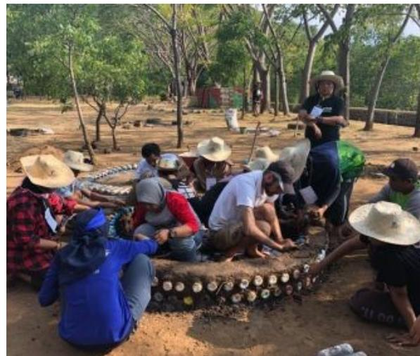
**La fabricación de ecobricks o ecoladrillos es un método de downcycling que consiste en envasar botellas de PET con plásticos no reciclables limpios y secos. Son una forma estupenda de mitigar la cantidad de plástico que se envía a los vertederos y al medio ambiente, y pueden utilizarse como bloques de construcción para edificaciones no estructurales (por ejemplo, bancos o pequeños muros).**
