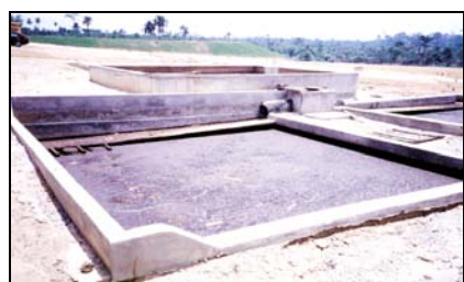
Photo 2: Sludge drying beds (Kumasi)
