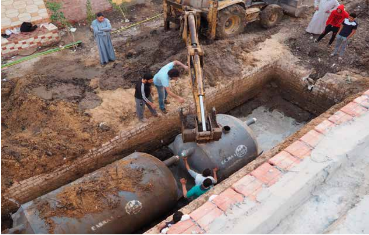
شكل 9: تنفيذ وحدة معالجة لا مركزية لمياه الصرف الصحي بالتعاون مع المجتمع المحلي بالعياط، محافظة الجيزة (مصر) (المصدر: مؤسسة بناء)
