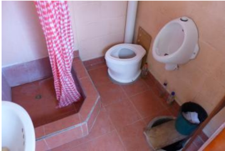
Ilustraciones 10 y 11: El retrete con separador de orina (movible), el urinario y las dos cámaras de deshidratación; los lodos son mezclados con materiales secos; las aguas de la ducha son separadas.
