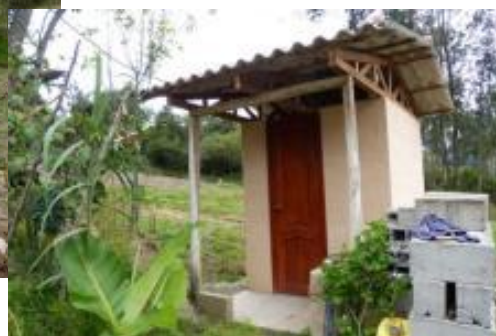
Ilustraciones 8 y 9: Retrete seco con separador de orina y tratamiento de aguas grises
