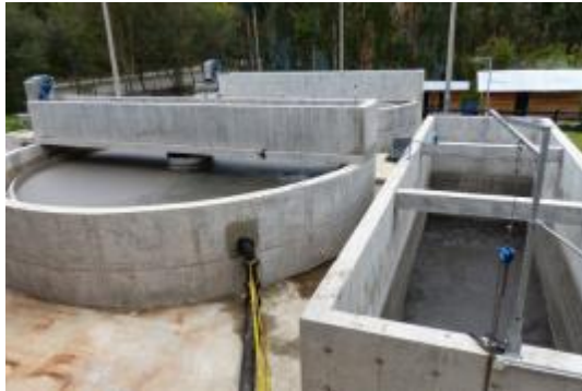
Ilustraciones 15 y 16: Estanque de espesamiento y filtros de banda en la planta de tratamiento de lodos de ETAPA
