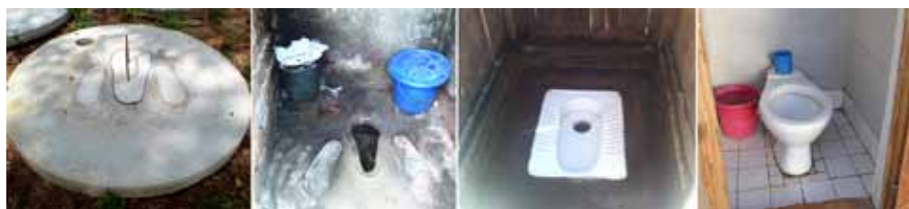
Différents modèles de dalles, de gauche à droite : dalle Sanplat, dalle maçonnée, cuvette céramique dans une dalle maçonnée, chaise anglaise avec sol carrelé.
