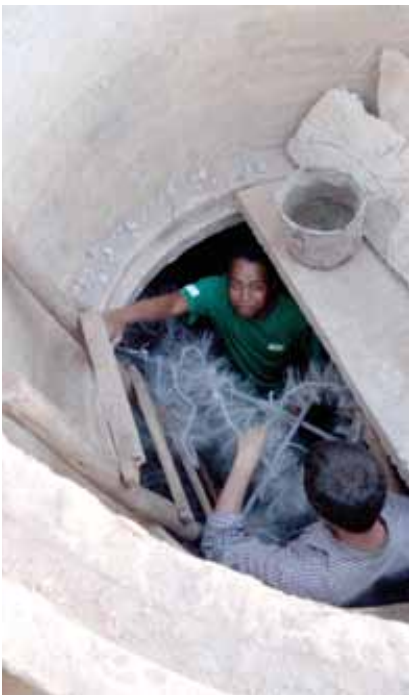
Mise en place d'un massif filtrant dans un filtre anaérobie à Madagascar.
