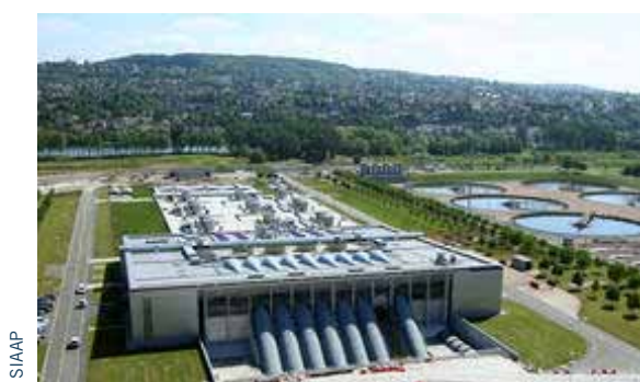
Usine de traitement Seine Aval (France).
