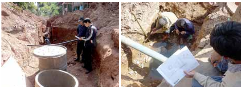
Construction d'un réseau d'égouts au Laos.
