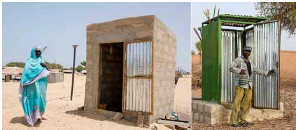
Différents modèles de superstructures en Mauritanie.
