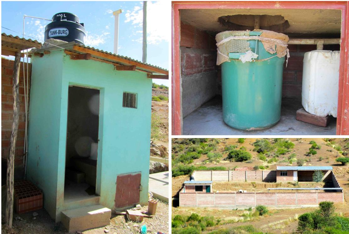
**Figura 2.5:** En sentido horario: Vista del exterior del baño ecológico de ADRA; Cámara con el tacho de heces y el bidón de orina; Planta de tratamiento en la OTB Llave Mayu.
