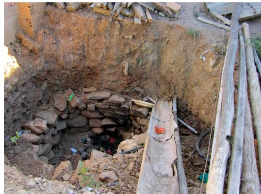
Figura 6.4: Construcción de un pozo ciego filtrante en la OTB Florida.
