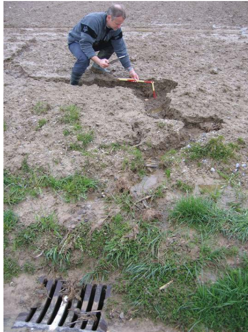
Abbildung 2.1: Die über Bodenerosion zur Gewässerbelastung beitragenden Flächen lassen sich im Feld gut kartieren. Erosionsrinne, die in einen Einlaufschacht und über diesen ins Gewässer mündet. Foto: Thomas Ledermann, CDE Uni Bern.
