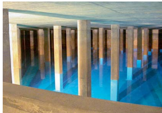
Abb. 8 Reservoir Lyren der Wasserversorgung Zürich: Zusammenschlüsse und Ringleitungen verbessern die Versorgungssicherheit. (Quelle: Wasserversorgung Zürich)
