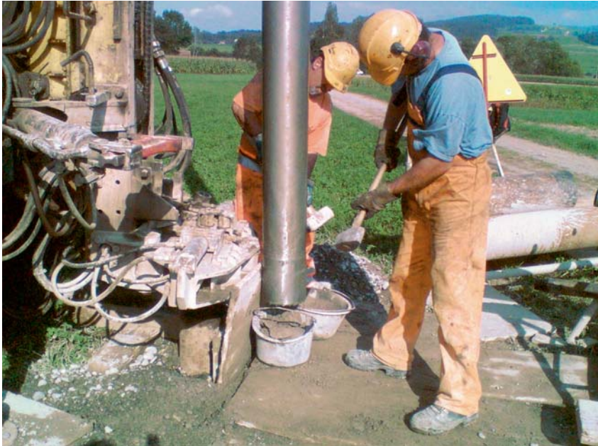
Abb. 7 Bohrung für die Erschliessung eines Grundwasservorkommens. (Quelle: WWA Bern)
