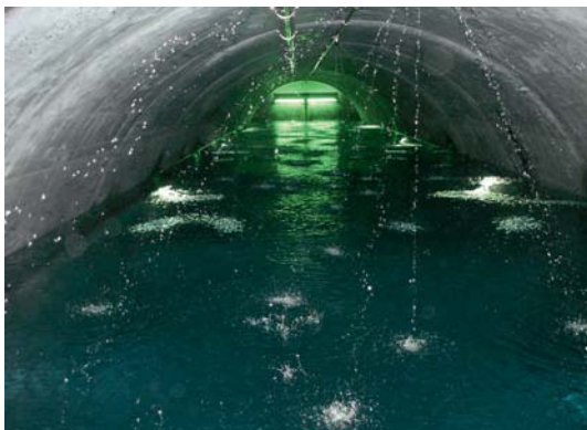
Abb. 5 Altes Tunnelreservoir: In der Schweiz fehlen vergleichbare Daten über das Alter und den Zustand der Infrastruktur zur Wasserversorgung. (Quelle: WWA Bern)
