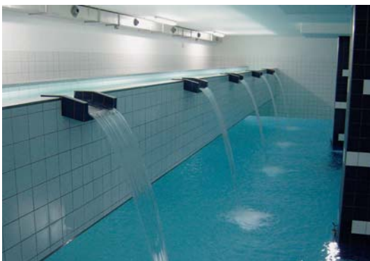
Abb. 6 Einlaufkrone in ein Reservoir: Mittlere und grosse Wasserversorgungen haben ihre Anlagen und Leitungsnetze kontinuierlich erneuert. (Quelle: WWA Bern)
