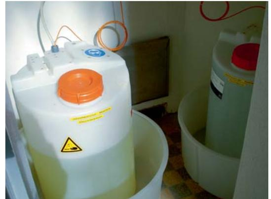
**Abb. 10** Das im Javelwasser enthaltene Chlor ist ein wirksames Desinfektionsmittel und wird hier automatisch zudosiert. (Quelle: WWA Bern)
