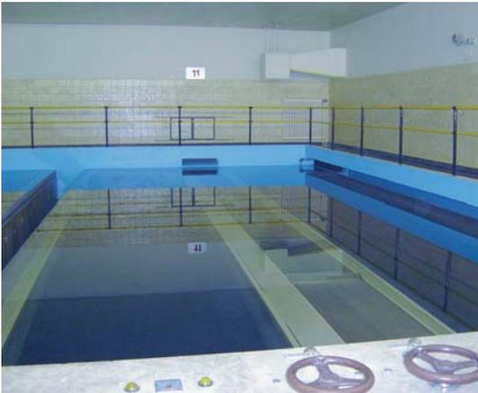
Abb. 3 Sandfilter – wie hier im Seewasserwerk Neuenburg – sind eine der ältesten Aufbereitungsmethoden. (Quelle: BAFU)
