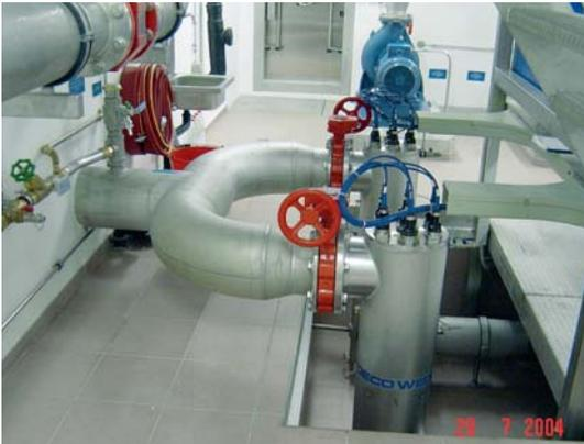
Abb. 11 Eine UV-Behandlung zur Desinfektion empfiehlt sich nur bei einer geringen Trübung des zu behandelnden Wassers. (Quelle: WWA Bern)
