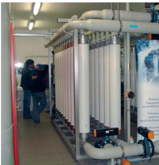
Abb. 8 Trinkwasseraufbereitung durch Ultrafiltration in Frutigen BE. (Quelle: WWA Bern)
