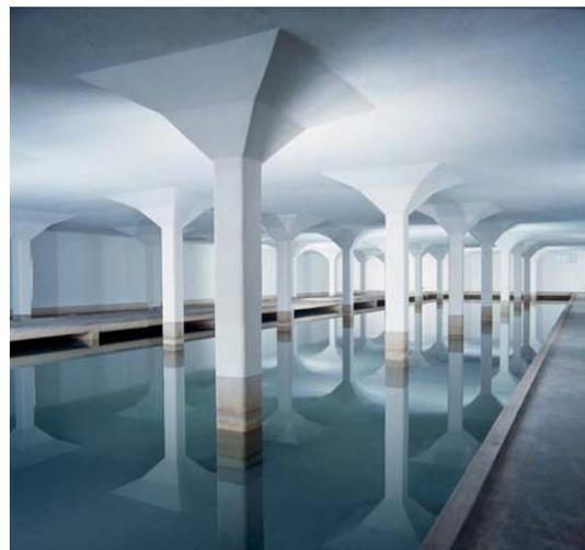
Abb. 6 Langsamfilter im Seewasserwerk Lengg der Wasserversorgung Zürich: Bei saisonalen Versorgungsengpässen kann die Seewasseraufbereitung als Puffer dienen. (Quelle: Wasserversorgung Zürich)
