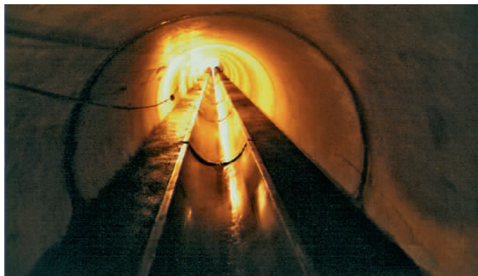
图 1 一个结合进污水管道的 200m 长的热交换器
