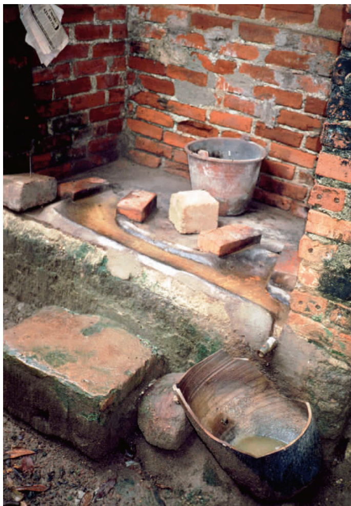
带有尿分离的双坑厕所(越南):厕所地上带有至两个粪便室的孔穴、一个尿分离沟和一个尿罐
