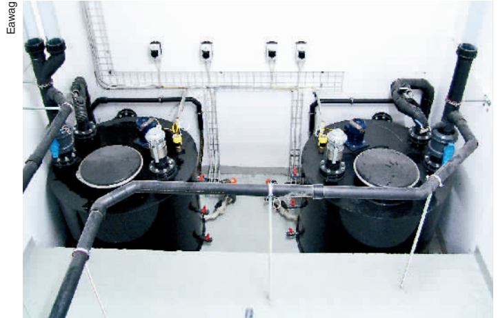
在 Forum Chriesbach, 尿也是从男性和女性使用者那里分别收集的, Eawag 新的总部大楼全部安装了非混合抽水马桶
