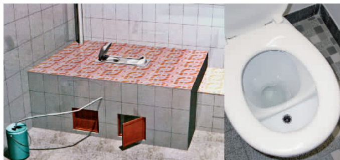
图2 2种尿分离卫生设备:无水便池(左)和非混合抽水马桶(右)
