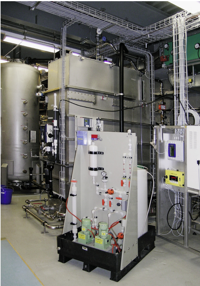
用于Lengg水厂苏黎世湖水处理的试验装置
