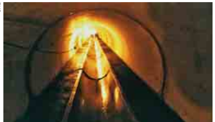
Abb. 1: Ein in die Kanalisation eingebauter 200 m langer Wärmetauscher.
