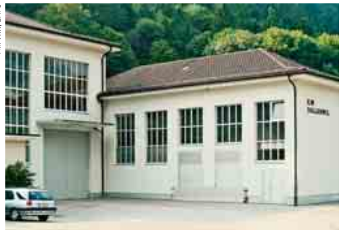
Abb. 3: Bei Hochwasser an der Engelberger Aa wird das Kraftwerk Dallenwil durch zusätzlichen lokalen Objektschutz gesichert.
