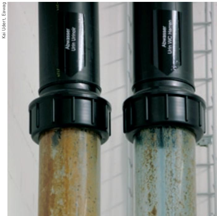
Les conduites d'évacuation des urines verticales et de grand diamètre permettent d'éviter les risques d'obstruction.
