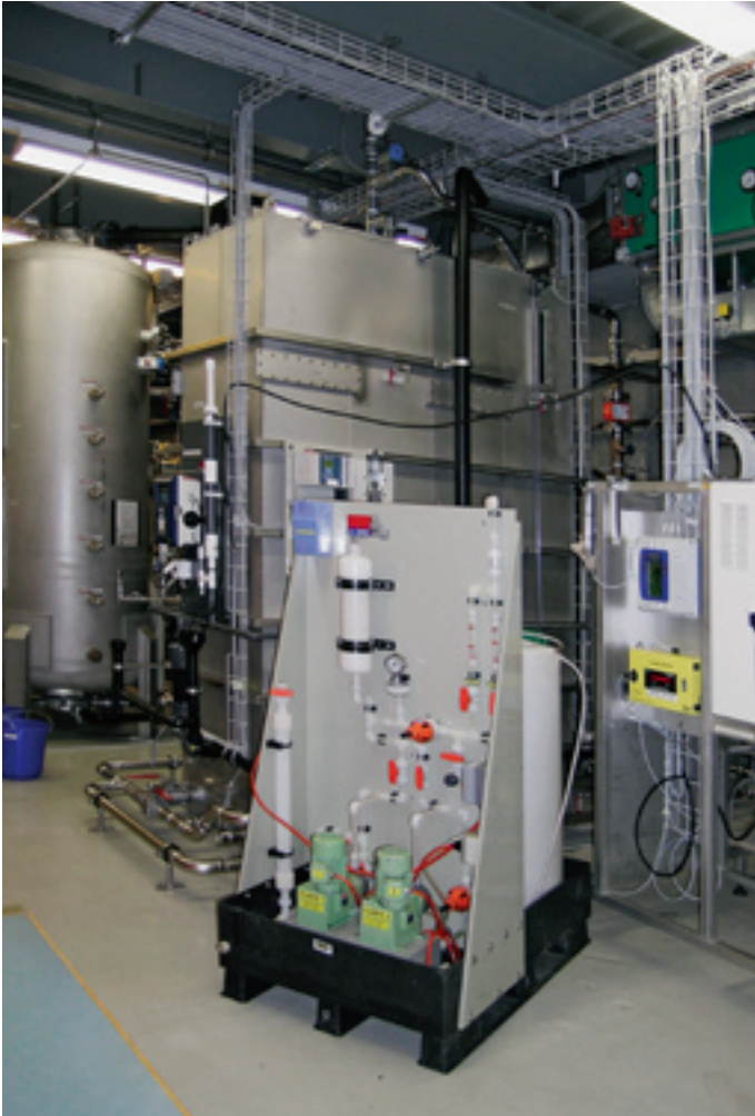
Pilotanlage zur Aufbereitung von Zürichseewasser im Werk Lengg.
