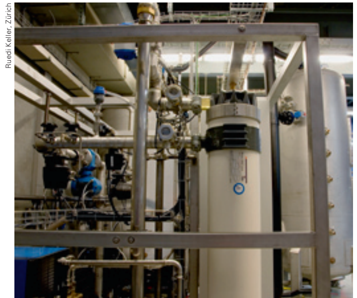
Das Membranmodul in der im Wasserwerk Lengg untersuchten Pilotanlage.
