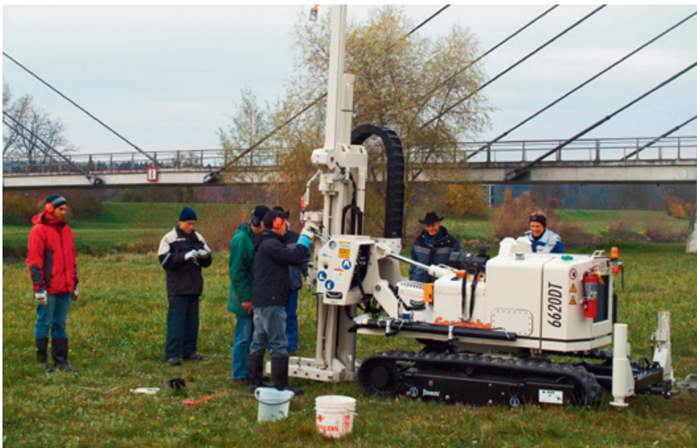
Bohrung für eine neue Grundwassermessstelle an der Thur bei Niederneunforn.
