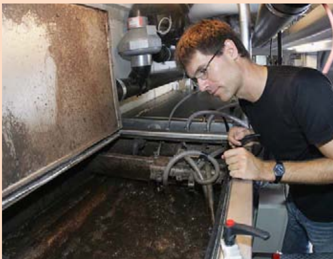
Nicht zu unterschätzen: Pilotkläranlage in einem Schweizer Einfamilienhaus.
