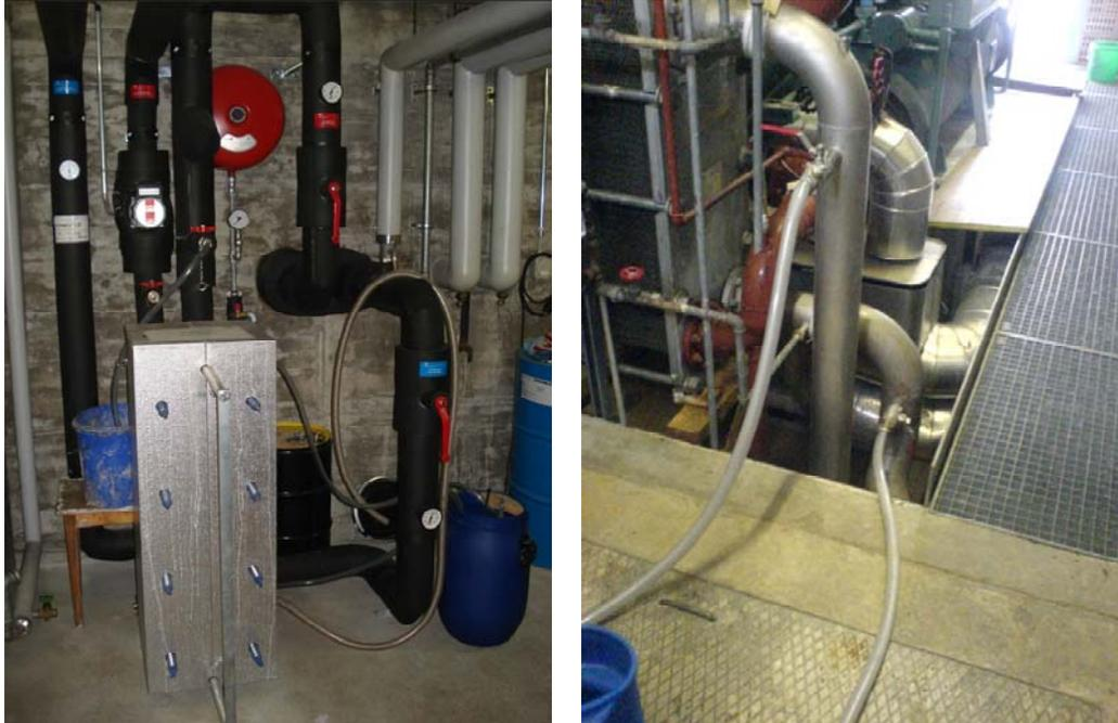
**Abbildung 27:** Vorrichtungen für die chemische Spülung, die von den Betreibern der Anlagen PT9 (links) und PT1 (rechts) selber entwickelt worden sind.
