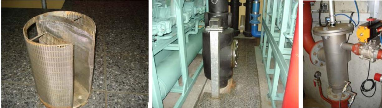
**Abbildung 22:** Vorfilter in den zwei unterschiedlichen Ausführungen. Siebkorb und Halterung (links und Mitte) und Bernoullifilter (rechts).
