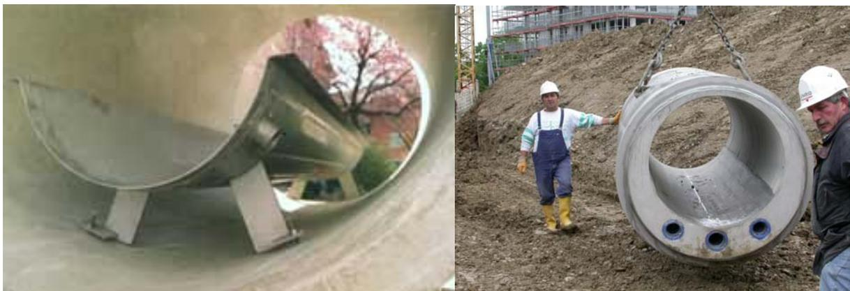
**Abbildung 5:** Rinnenwärmetauscher werden in bestehende Kanalisationsrohre eingebaut (links) oder werden bereits bei der Fertigung in diese integriert (rechts).
