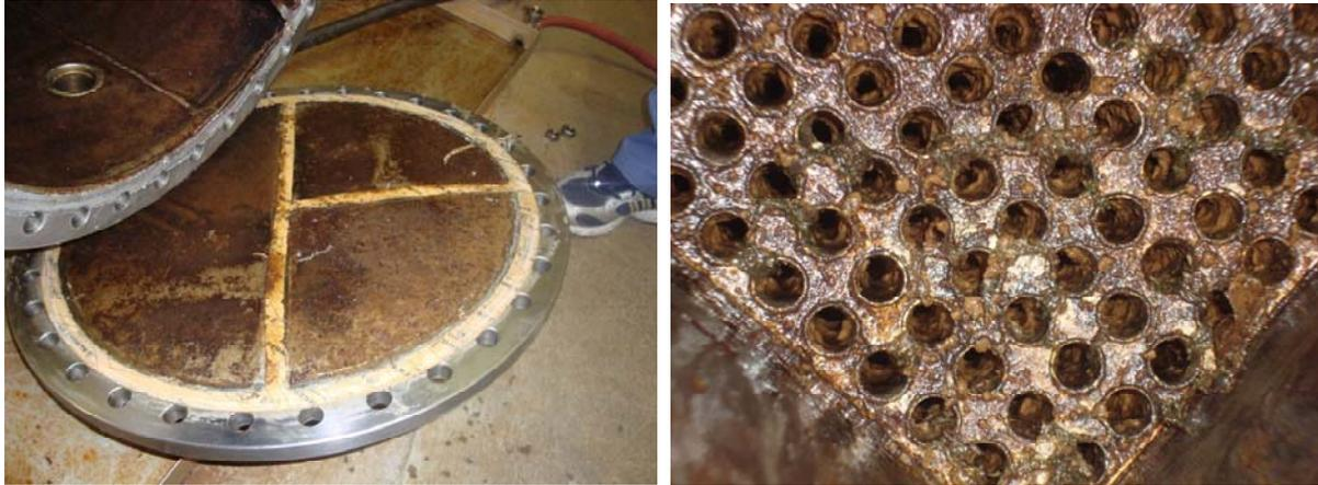
**Abbildung 13:** Probenahmestellen am Deckel und in den Rohren.
