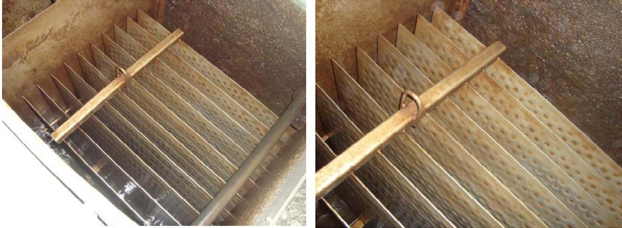
**Abbildung 16:** Offener Plattenwärmetauscher mit 40 Millimetern Plattenabstand.
