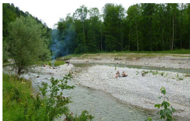
Die Töss oberhalb Winterthur (ZH); oben mit Sohlswellen und Uferverbau, unten aufgeweitet. (Fotos: A. Bryner)
