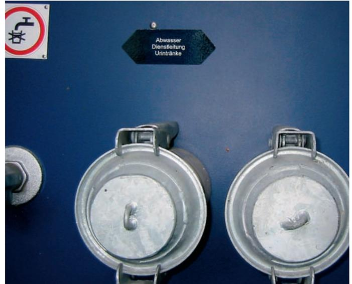
Urin frisch ab Fass: Bei Bedarf kann an der Entnahmestelle im Forum Chriesbach der Urin in einen Tankwagen gepumpt werden (Foto Karin Güdel)
