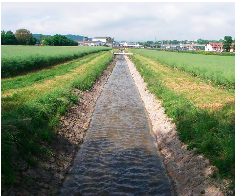
Abb. 2: Mangelnde Vernetzung: Uferbefestigungen und verdichtete Flusssohlen wie hier bei einem Zufluss zum Neuenburgersee verunmöglichen den Austausch mit der Umgebung.
