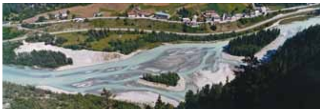
Fig. 12 L'Inn à Tschlin GR avant (au-dessus) et après les travaux de revitalisation (au-dessous). Le tronçon réaménagé s'étend sur 1 km et les travaux ont coûté 2,6 millions de francs.
