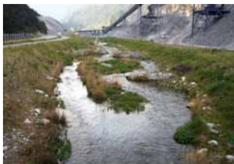
Fig. 11 Walenbrunnen dans le canton d'Uri. Au-dessus, un tronçon canalisé, au-dessous, le tronçon revitalisé.
