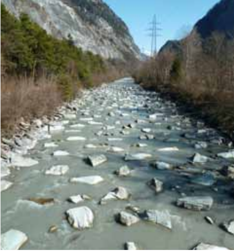
Fig. 13 Élimination d'obstacles: une rampe à blocs réaménagée dans la Landquart près de Malans GR. Photo: Armin Peter
