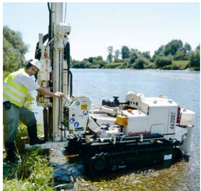
Abb. 3: Installation eines Grundwasserbeobachtungsrohrs (Piezometer) am revitalisierten Abschnitt der Thur mit der Geoprobe, einem Rammgerät.
