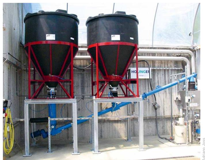
Pilotanlage zur Dosierung von Aktivkohle direkt auf den Sandfilter in der ARA Ergolz 1 in Sissach (BL). Sie besteht aus zwei Kohlesilos und einer Wägeinheit mit Befeuchtung (ganz rechts im Bild).
