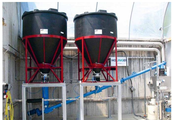
Pilote d'apport direct de charbon actif au filtre à sable à la STEP d'Ergolz 1 à Sissach (BL). L'installation se compose de deux silos à charbon et d'une unité de pesée avec humidificateur (à droite sur la photo).
