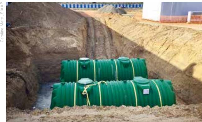
Einbau der Urin-Lagerbehälter auf der Baustelle der Kläranlage Seine-Aval in Achères.
