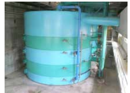
Ansicht nachgeschalteter Sandfilter
