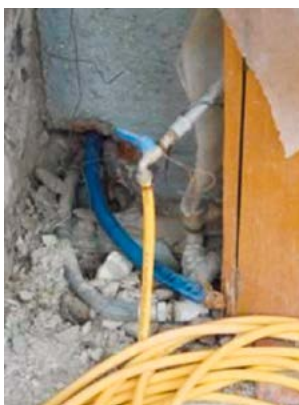
Fig. 2 Verunreinigte Schläuche und Gerätschaften, die zur Erstbefüllung, Dichtheits- und Festigkeitsprüfung verwendet wurden
