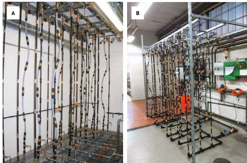
Fig. 3 Die automatischen Testsysteme an unterschiedlichen Standorten (A und B) Les systèmes d'essai automatiques à différents emplacements (A et B)
