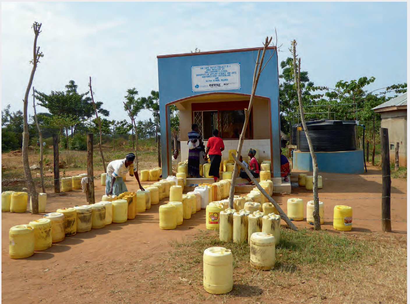
Fig. 1 Wasserkiosk in Uganda. Das aus dem Lake Victoria stammende Wasser wird mit der schwerkraftgetriebenen Membranfiltration, kurz GDM, behandelt. Kiosque à eau en Ouganda. Eau provenant du lac Victoria traitée par filtration par membrane gravitaire (ou GDM).
