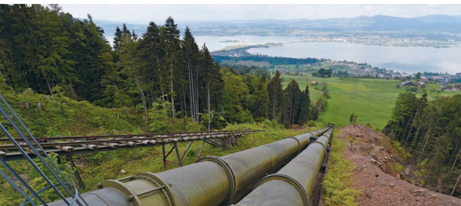
Aus 2 wird 1: Die Druckleitungen werden durch eine grosse ersetzt – bei gleicher Kapazität.
