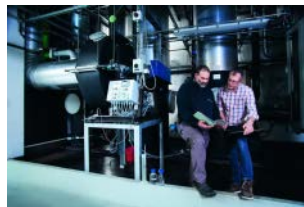
Installation de stripping à l'air servant à la récupération de l'azote dans la station d'épuration d'Opfikon. Photos : Eawag, Peter Schönenberger (à gauche), Eawag, Aldo Todaro (à droite)
