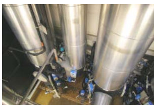
Installation de strippage à l'air servant à la récupération de l'azote dans la station d'épuration d'Opfikon. Photo : Eawag, Yvonne Lehnhard
