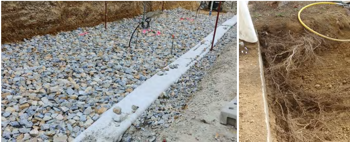
Abbildung 86: Bilder vom Projektstandort während der Bauphase (links: Grobschlag als tragfähige Unterbaukonstruktion für Neupflanzungen auf der Westseite; rechts: mit Druckluftlanze freigelegte Wurzeln eines Bestandsbaumes auf der Ostseite) (eigene Aufnahmen)
