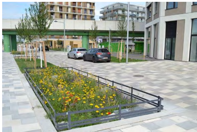
Abbildung 22: Schwammstadtstraße mit Dualem Tiefbeet und Baumpflanzungen (Juni 2022)
