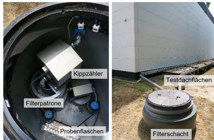
Abb. 3: Pilotfilter zur Regenwasserbehandlung am Standort Berlin. Links: Blick in den geöffneten Schacht, rechts: Aussenansicht des Schachtes und der angeschlossenen Flächen.
