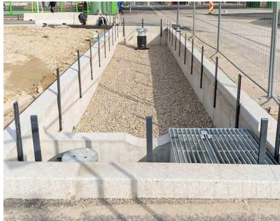
Abbildung 230: Duales Tiefbeet – Rohbau vor Integration des Filtersubstrats und der Bepflanzung (Fj 2022)
