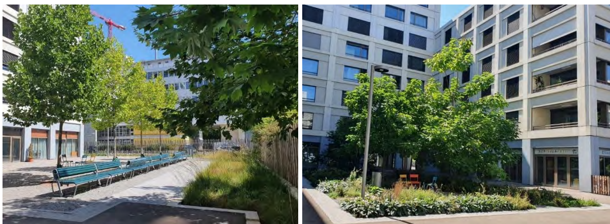
Abbildung 10: Rückhalt und Versickerung von Regenwasser in bepflanzten Gräben (links), Park mit Bäumen im Innenhof über Tiefgarage (rechts)
