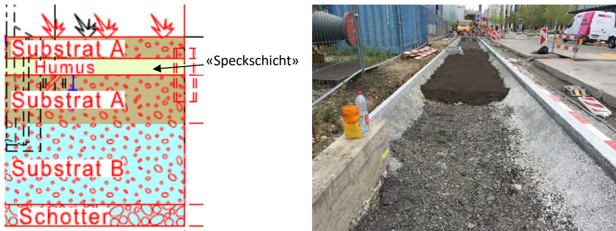
Abbildung 8: Schwammstadt-Substrat Stadt Zürich – Aufbau (links) und Einbringung (rechts)
