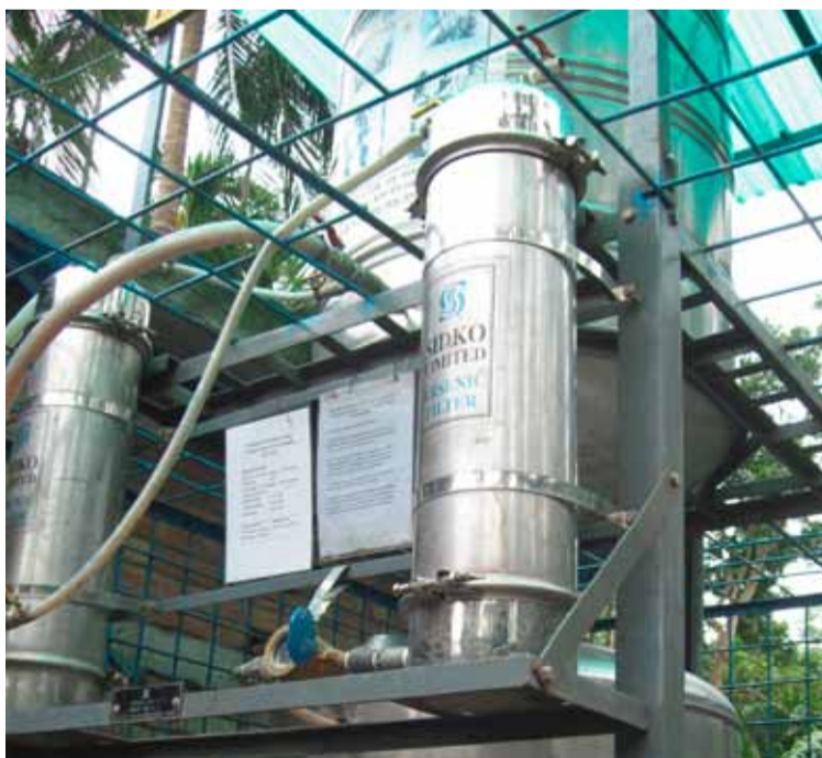
Abb. 5: Eine Filteranlage zur Elimination von Arsen in einer Gemeinde in Bangladesch. Filter aus Knochenkohle in einem Haushalt in Äthiopien.
